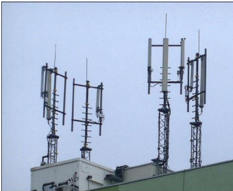
Obr. 1 Základnová stanice (BTS) se sektorovými anténami
